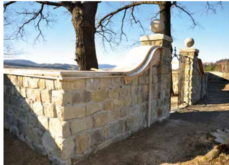
Die sanierte Friedhofsmauer am Kriegerfriedhof Nr. 78 Sękowa
